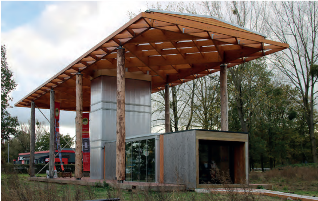
Het GTB-Lab. Onder het losstaande houten dak staat een stabiliteitskern van staal, waar verschillende verdiepingen op kunnen worden aangesloten.
